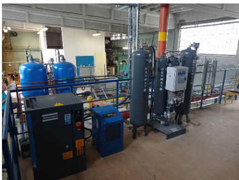
V popředí část jednotky ozonizace (kompresor, sušička vzduchu, zásobník stlačeného vzduchu, generátor kyslíku o čistotě 93 %, zásobník stlačeného kyslíku, generátor ozonu je v místě fotografie), v pozadí 2 ks GAU filtrů.
