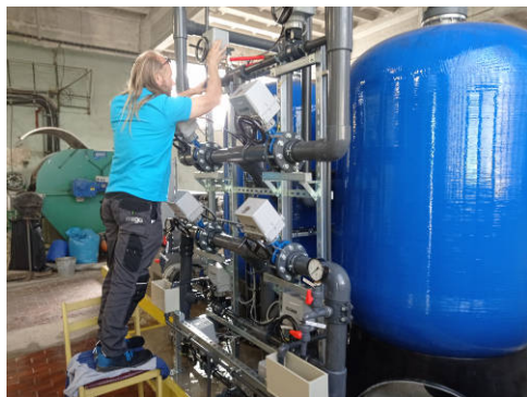
Vedoucí technolog DVH, Michal Cypris, při montáži ventilů s elektrickým pohonem pro GAU filtraci.
