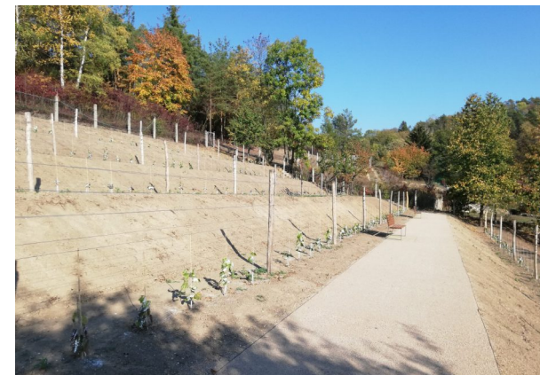
Vinice po úpravě
