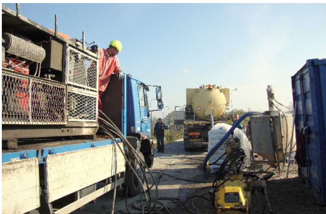
Aplikace tlakové injektáže vápenného mléka do vrtů u lagun OSTRAMO
