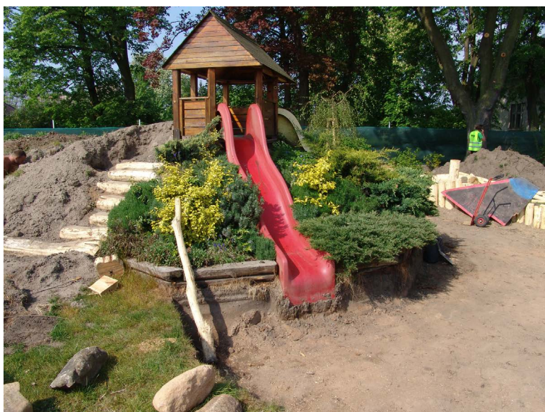
Výstavba hřiště u Mateřské školky v Lysé nad Labem
